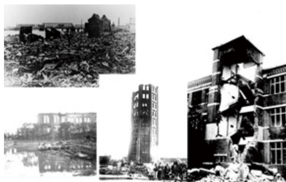
図5 1923 関東大震災による被害
