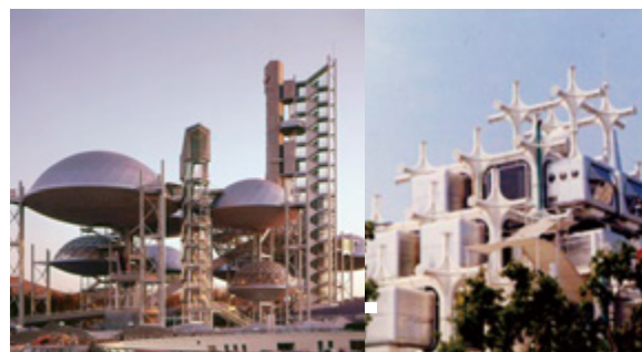
住友児童館:組柱により支えられ宙に浮遊する単層ラチスドームユニットは、木村俊彦により単純メタボリズムの具現化。部屋ユニットは自由な振動モデルを用いて解析・設計された。タカラ・ビューティリオン:黒川紀章によるメタボリズムの具現化。部屋ユニットは自由に組み替え、移動が可能。
