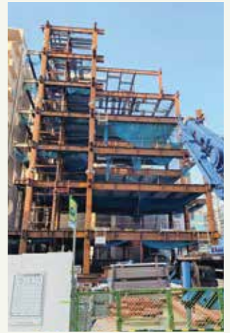
鉄骨工事の様子
