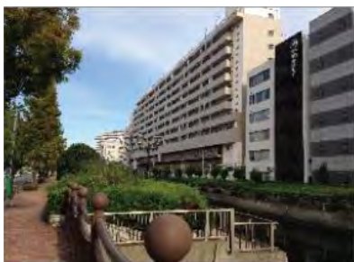
写真3 設計敷地と前面運河
