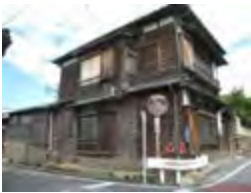
写真1 木造民家(秩父)
