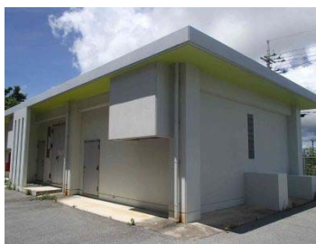
久松ポンプ場 建設年度 平成24（2012）年度
