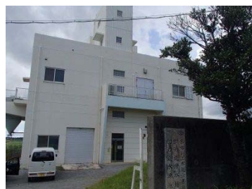
加治道浄水場 (管理棟)
