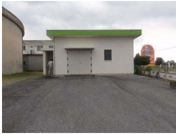
袖山浄水場送水ポンプ室 建設年度 平成元（1989）年度
