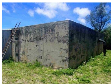
第三配水池 (南区)
