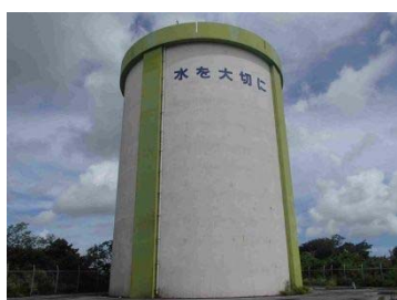
二重越第二配水池
