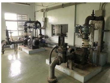
加治道水源地
