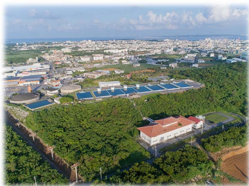
袖山浄水場と本市市街地
