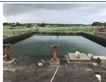
加治道浄水場 (緩速ろ過池)
