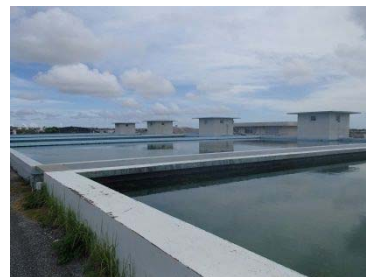
袖山浄水場 (緩速ろ過池)
