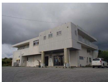
袖山浄水場 (管理棟)
