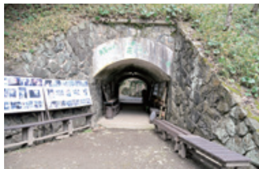
地下倉庫入口
