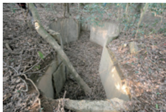
コンクリート構造物(レーダー基礎、南・送信機)
