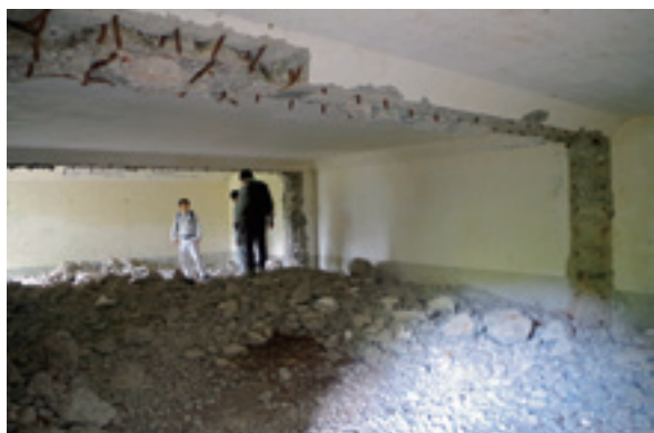
第2砲座砲側弾薬庫 (内部)
