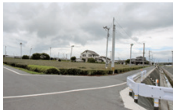
区画溝・道路
