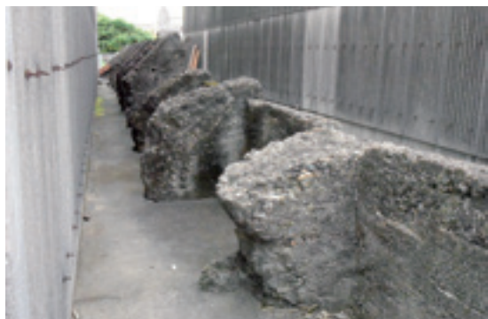
建物コンクリート基礎
