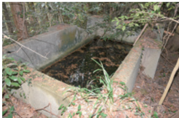
コンクリート構築物
