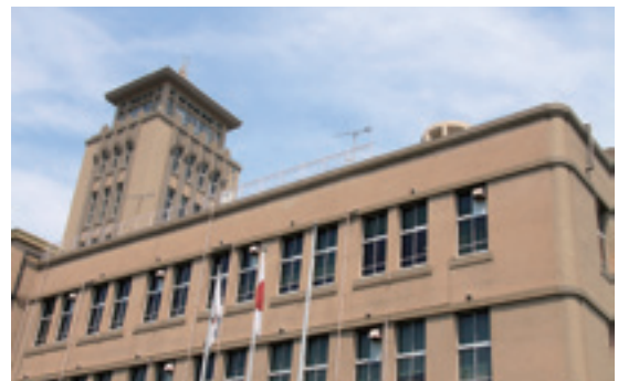
大牟田市役所庁舎と防空監視哨
