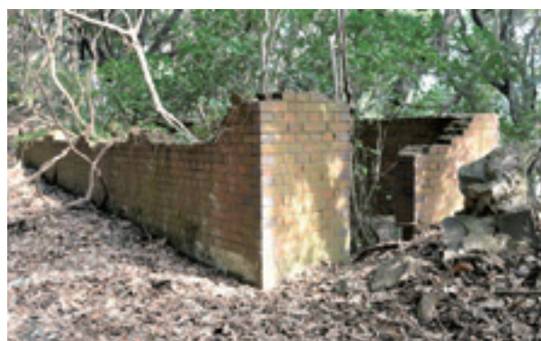
煉瓦造建造物
