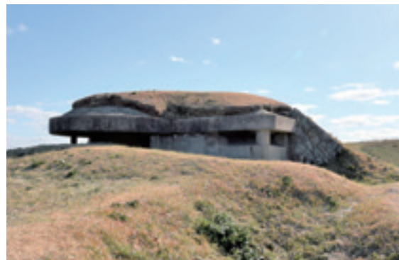
観測所（指揮室・通信室）
