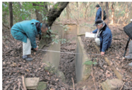
コンクリート構造物(レーダー基礎、南・送信機)
