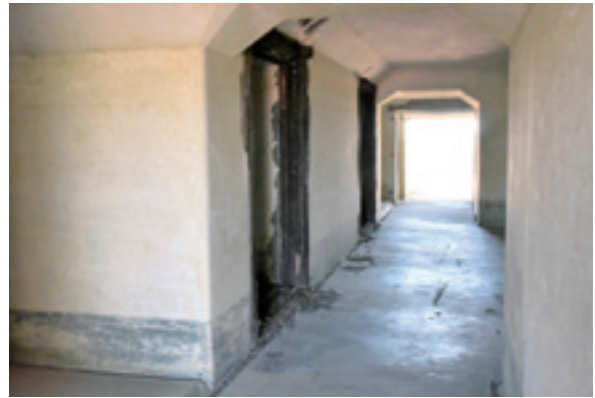
2・3号砲側弾薬庫
