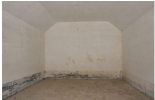
2・3号砲側弾薬庫（内部）
