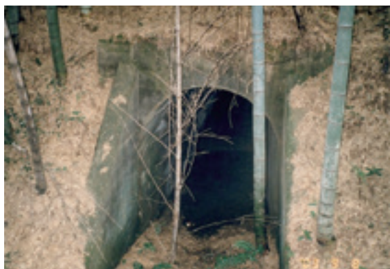
監的壕へのトンネル（上、右）（2003年撮影）
