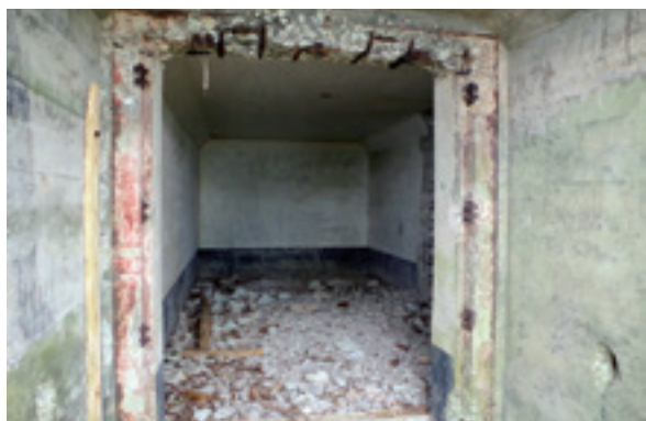
第1砲座砲側弾薬庫 (内部)
