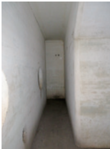
弾薬支庫 (第2弾薬庫)
