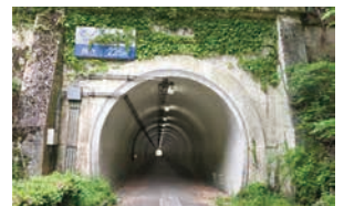
老ノ坂トンネル
