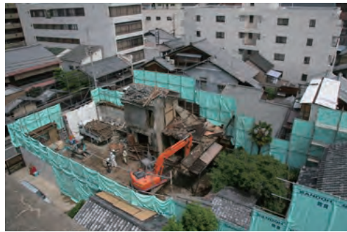
解体される京町家
