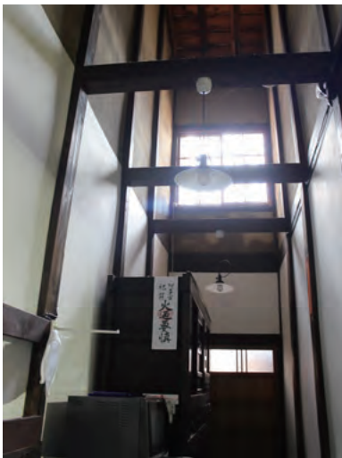
高窓からの光が降り注ぐ火袋。「火遇要慎（ひのようじん）」の御札（おふだ）が京町家を見守ります。
