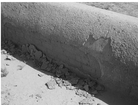
第6図 崩壊した修復部分
