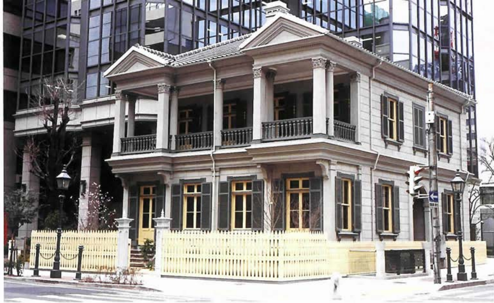
国指定の重要文化財に指定された、復旧工事後の「十五番館」
