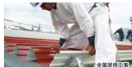
金属屋根工事
