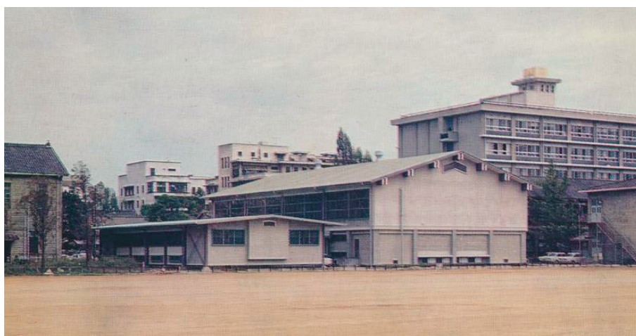
建設後間もない頃の体育館（右）と武道館（左）
