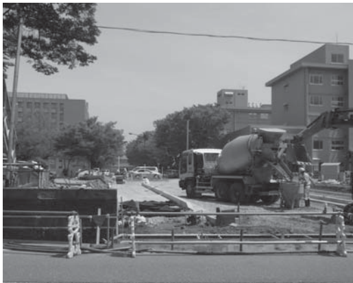
写真1 市道側から見た工事中の新正門付近
