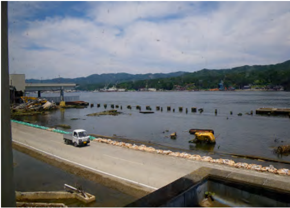
写真 1. 水産振興センター2 階から撮影した魚市場(道路の奥はかつて市場の一部であったが、地盤沈下により、海水の下に沈んでいる).
