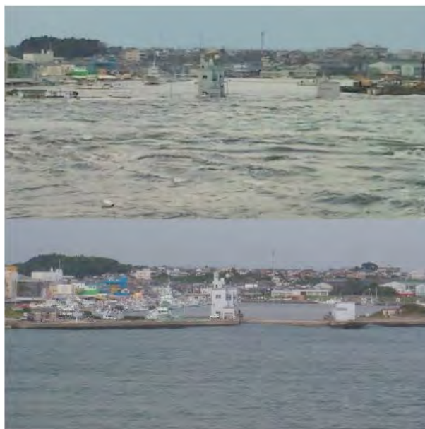
図2. 水族館からみた河口対岸的那珂湊漁港. 津波到達時(2011年3月11日撮影)は河口より海水が逆流し、堤防も水没した(上). 下は平常時(2011年8月6日撮影).
