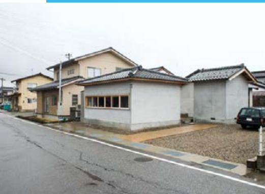
敷地は、高岡市の住宅地にある。
