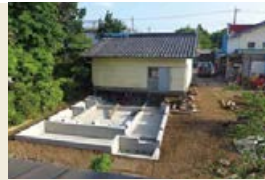
2 座敷の土台の下にレールをかませ、水平移動。
