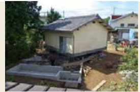
3 新しい基礎の上ののせる。
