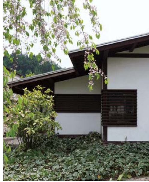
移築後の「願空庵」の外観。白井晟は、白い漆喰壁とくすんだ木部との階調を好んだ。
