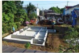
1 曳家したい場所に、基礎を新設。
