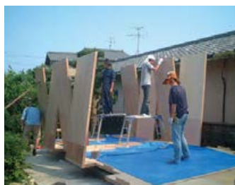
写真右／別方向に傾く2種類の口の字フレームを交互に連結している。写真左／施主と建築家のセルフビルドによる組み上げ。
