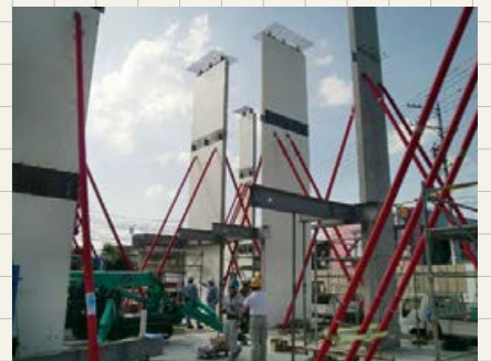
写真右／林立している壁柱。赤いポールは施工中の支え。左／竣工後。
