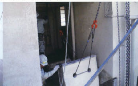
解体材の撤去は人力とレッカー(重機)で。
