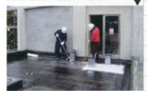
屋根防水工事。
