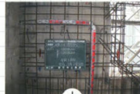
妻壁開口新設
