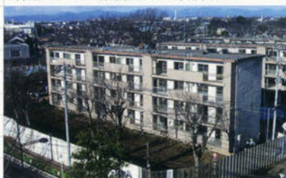
改修前のC棟。
