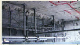
解体工事完了。
