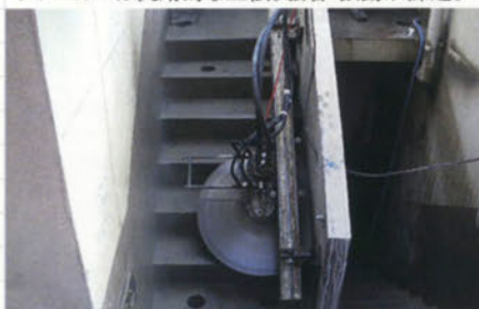
ウォールソーによる解体(右2点も)。
