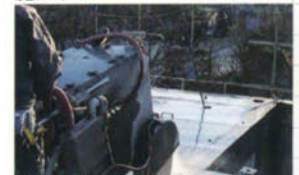
既存屋根の大割解体。
