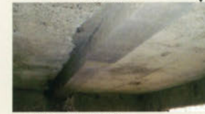
コンクリート打設後。
