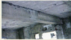
コンクリート打設後。
