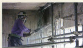
ブレイカーによる解体。
