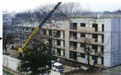
改修工事の様子。
