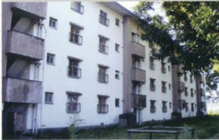
階段室側外観
