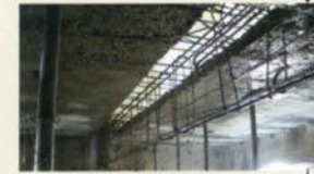
スラブの一部も撤去。
