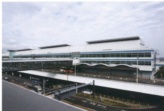
今回増築されたターミナルビル右袖部分。
