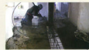
ウォータージェットによる解体。
