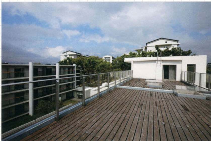
C棟屋上テラス(減築された部分)。
