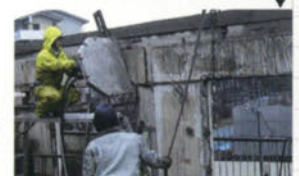
4階壁梁の解体。
