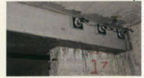
PC鋼棒緊張後。
