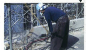
切断端部の補強 補修。
