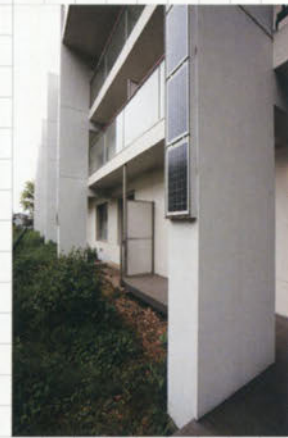
写真右／南面には、躯体改変による構造のバランス変化を補うために板状の柱を新設して構造を補強。
