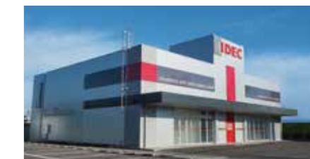
協調安全ロボットテクニカルセンター(愛知県)
