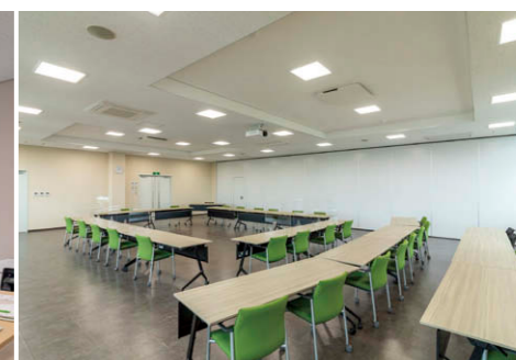
会議室 可動式間仕切りによるフレキシブルな利用をふまえてLEDベースライトTENQOOスクエア②を採用。
