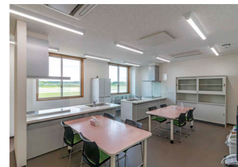
多目的室 調理が行われる多目的室では LED ベースライト TENQOO シリーズ防湿・防雨形④を採用。
