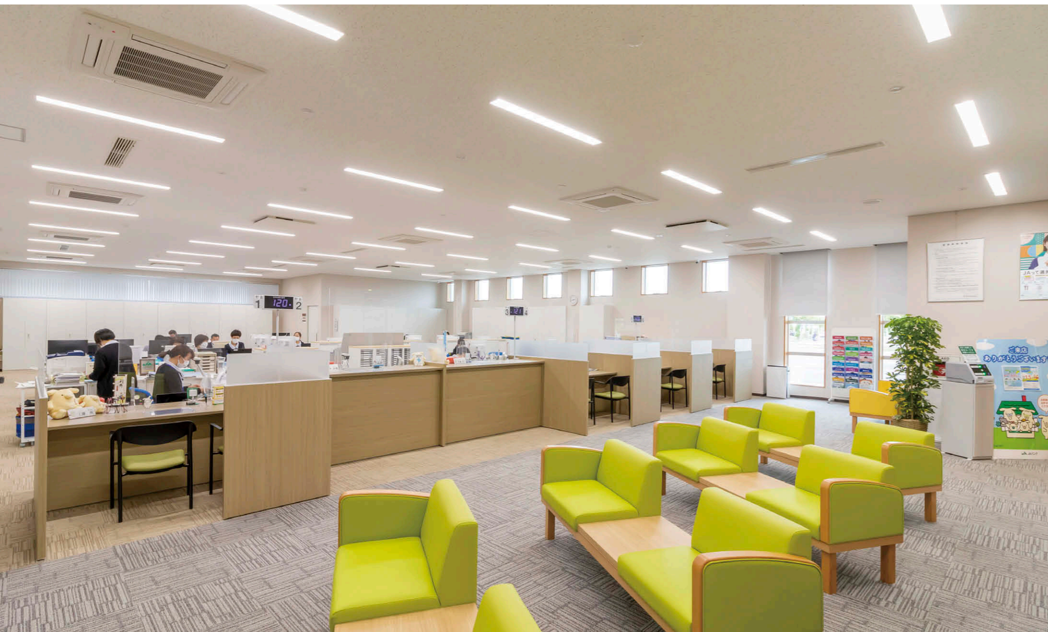
1階執務室エリア(金融共済部) 調光タイプの LED ベースライト TENQOO シリーズ埋込形①と「あかり+人感センサー」により省エネ効果を向上。
