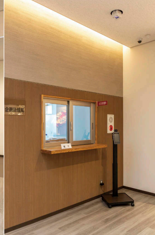
企画管理部 来客窓口 人が対面する窓口上部に配置し、手が触れるカウンターまわりを除菌。
