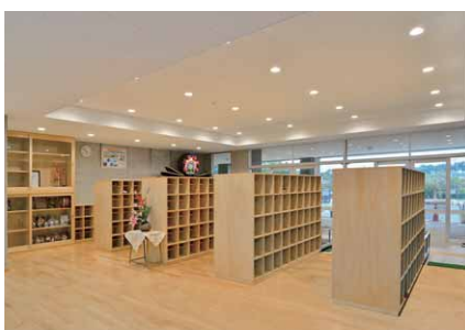
昇降口のLEDライトエンジンダウンライトによる照明
