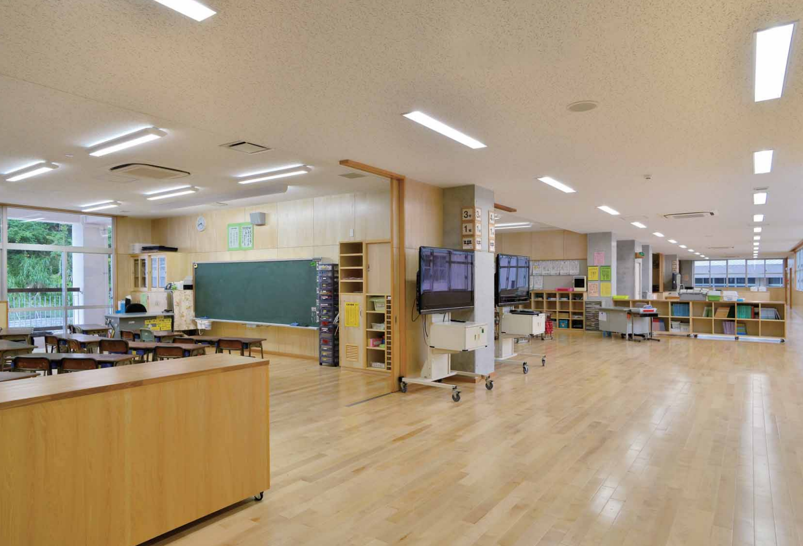
高学年普通教室を多目的スペースから奥を望む AQシリーズ直付形スクールソフト調光タイプを均等配置
