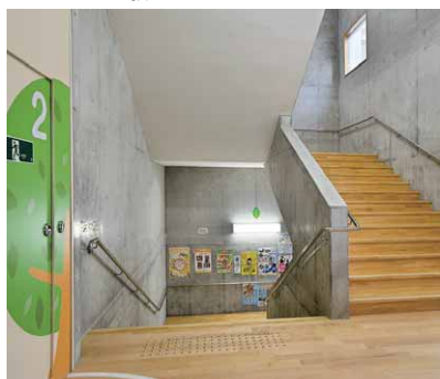
階段ホールのLED照明
