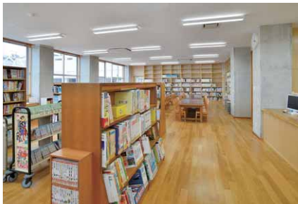
図書室のLED照明(調光タイプ)
