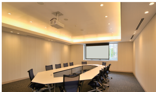
各階に配された会議室 LED間接器具でやさらかな光で包み込み、周囲のLEDダウンライト調光形で適切なあかりを確保
