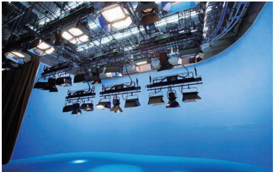
第2スタジオの照明設備 Lパトン13台、バックパトン3台、アッパー水平パトン3台、美術パトン2台等を配置
