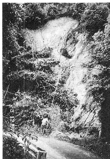
写真-4 まさ土斜面の崩壊状況 (宮之城町市野E; No.5(5))
