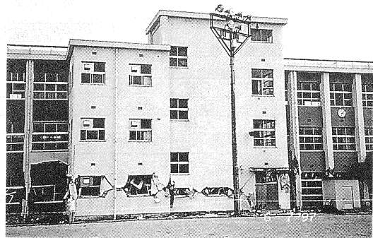
写真-14 宮之城高校の被災状況 (宮之城町屋地; No.2)
