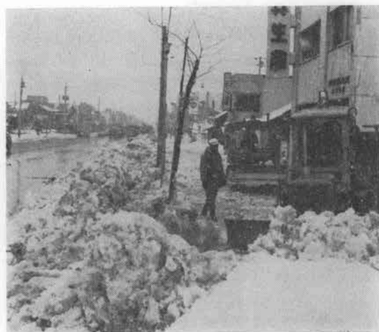
写真-11 小形ブルドーザによる歩道除雪
