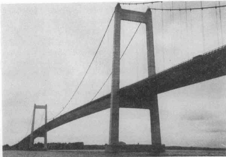
写真-1 Fyn側から見た全景
