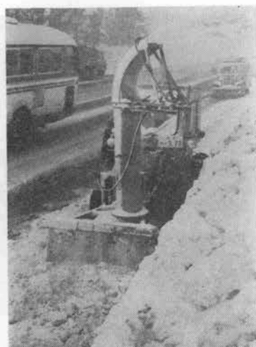
写真-12 小形ロータリ除雪車による歩道外への放雪作業
