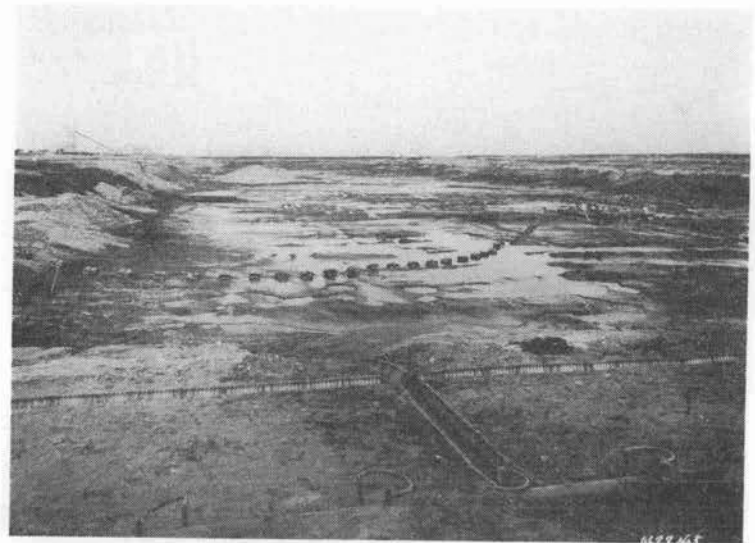
→ 写真-1 排水後のドック内の ヘドロ堆積状態
