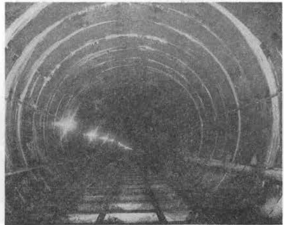
写真-2 取水トンネル坑内SCセグメント覆工
