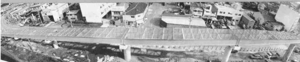
▼築港側取付部上部工の架設
