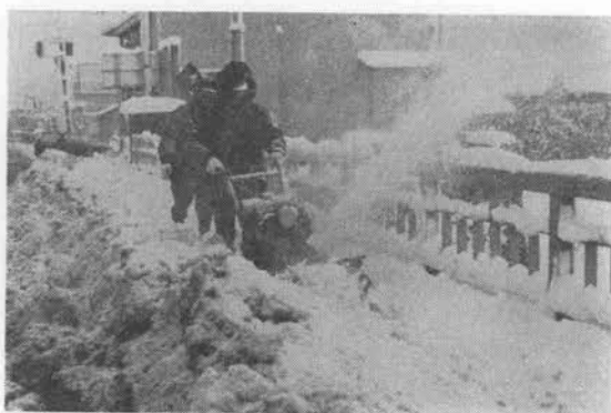
写真—16 ハンドガイド形小形ロータリ除雪車 による橋の歩道部分の除雪
