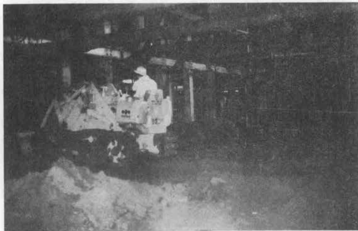
飯田橋付近における機械掘削の状況
