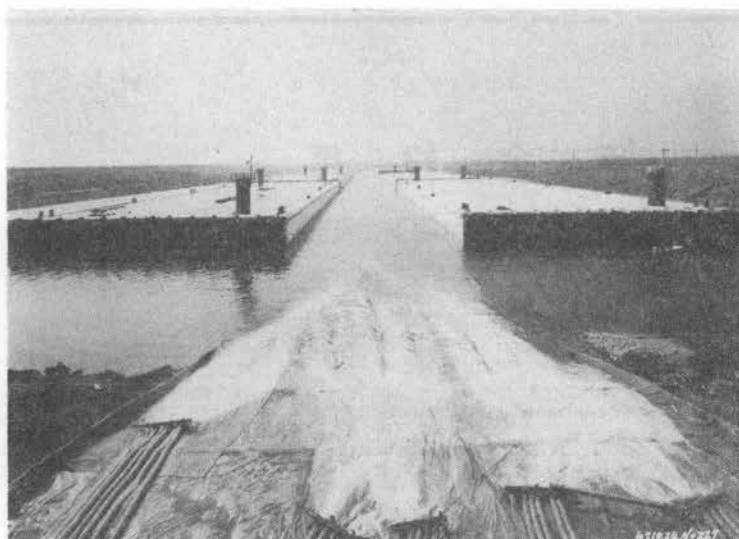
写真-3 エレメント完成後の ドック内への注水
