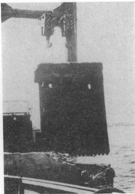
写真-1 障害物撤去工事(その1)
