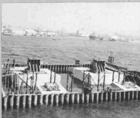
▼主橋梁中間橋脚(南港側)上部沓据付 (重量(片沓)約 200t)
