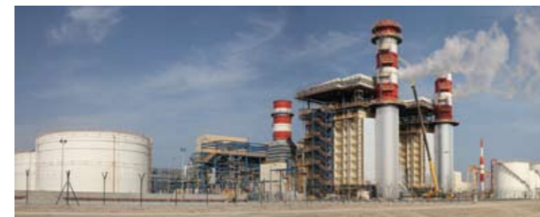
バルカ3 IPP (独立系発電事業) プロジェクト (オマーン)
