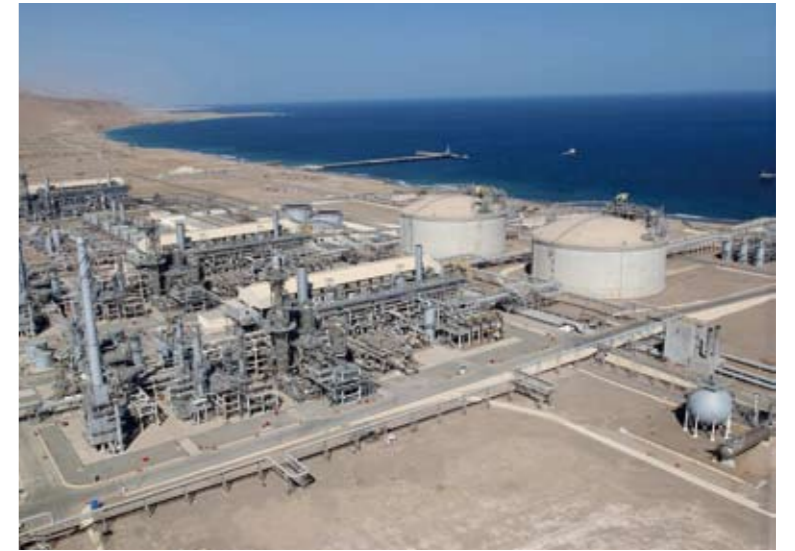
当社が完工したオマーンLNGプロジェクト(写真手前の2系列)・カルハットLNGプロジェクト(写真奥の1系列)の航空写真(写真提供:オマーンLNG)
