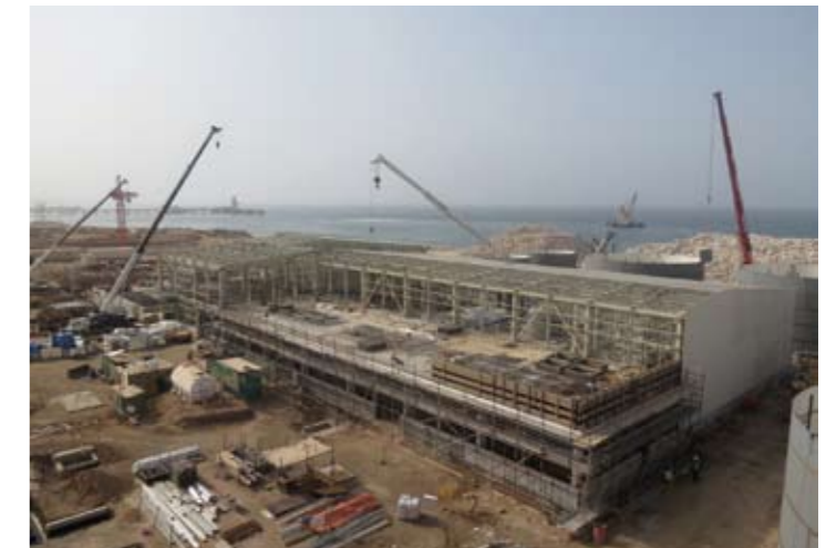
スール発電所建設現場（水処理棟）
