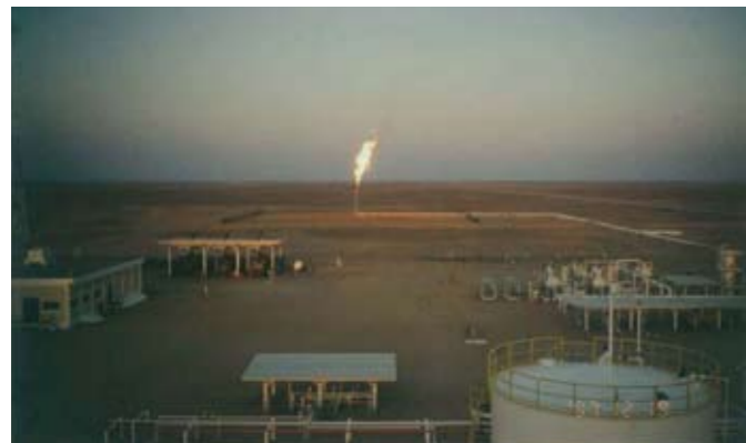
原油生産施設の写真
