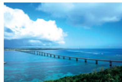
⑤宮古島市【伊良部大橋】
