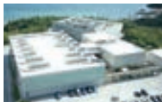
《宜野座サーバーファーム》 NTTビジネスソリューションズ クラウドサイトテクノロジー
