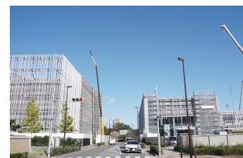
建設が進む現地（2021年10月撮影）
