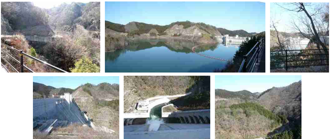
ダムの取水口の真上からはトウトウと流れ落ちる水、周りの山は芽吹き春の山を独り占め
