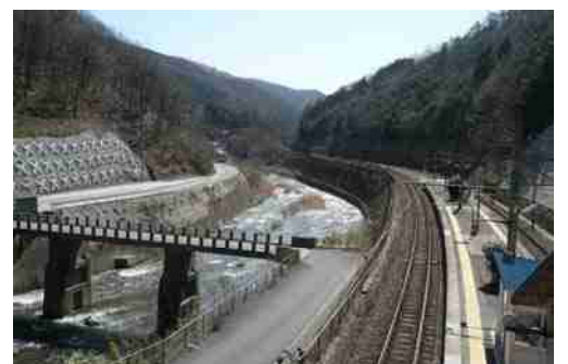
足立駅より南側 神代・新見方面側
