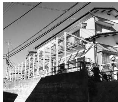
茨城大学学生用シェアハウスリフォーム工事現場
