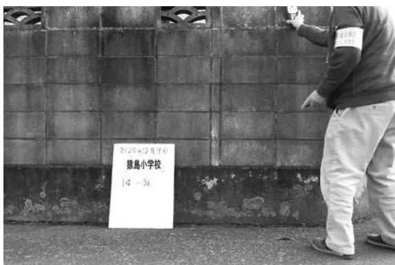
ブロック塀調査
