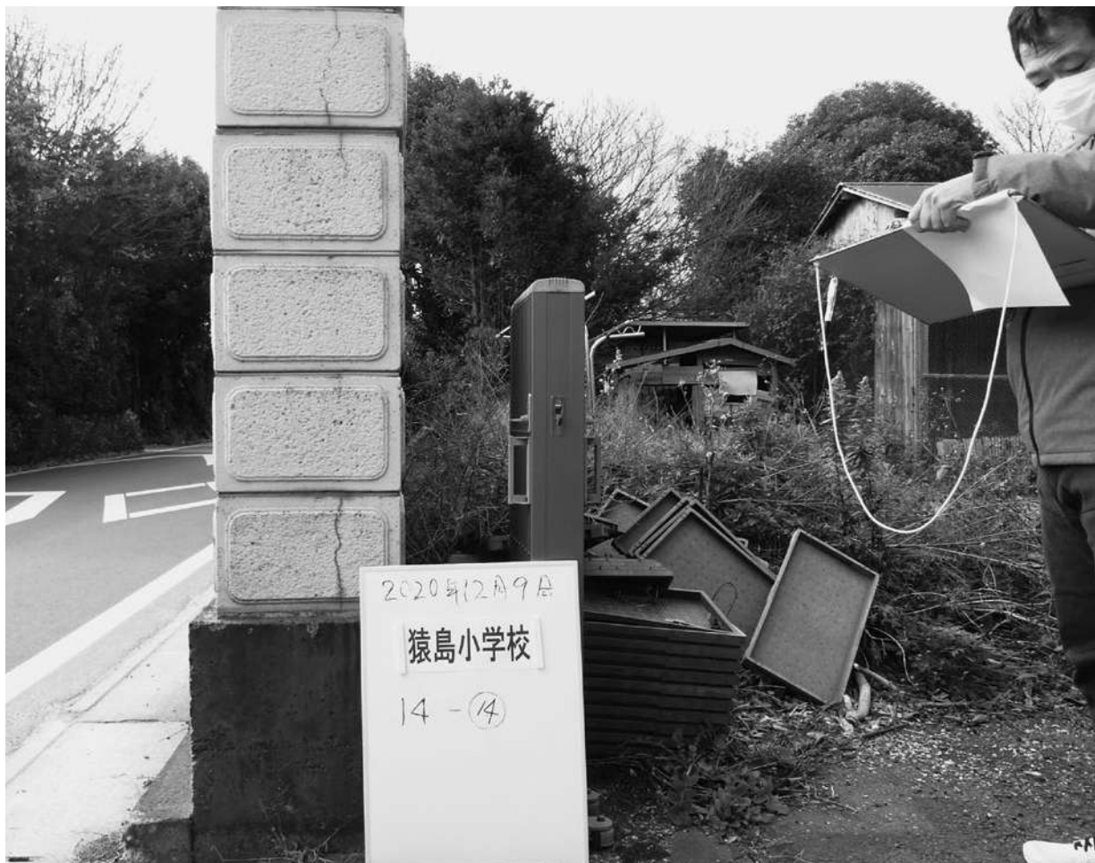
境町の猿島小学校通学路沿いにあるブロック塀の調査を、境町の依頼により実施
