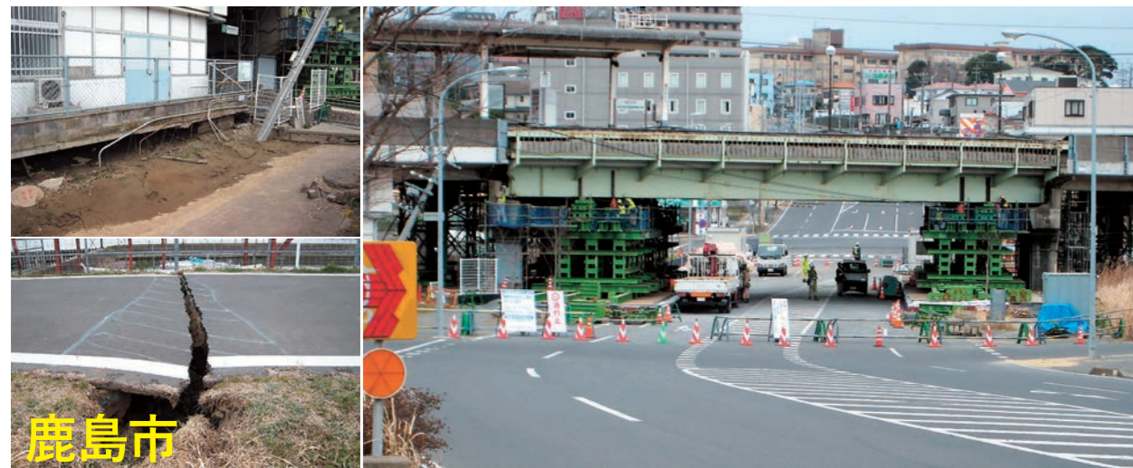
液状化による被害も各地に大きな爪痕を残す。地盤が沈み、高架線路も下がってしまった(右)
