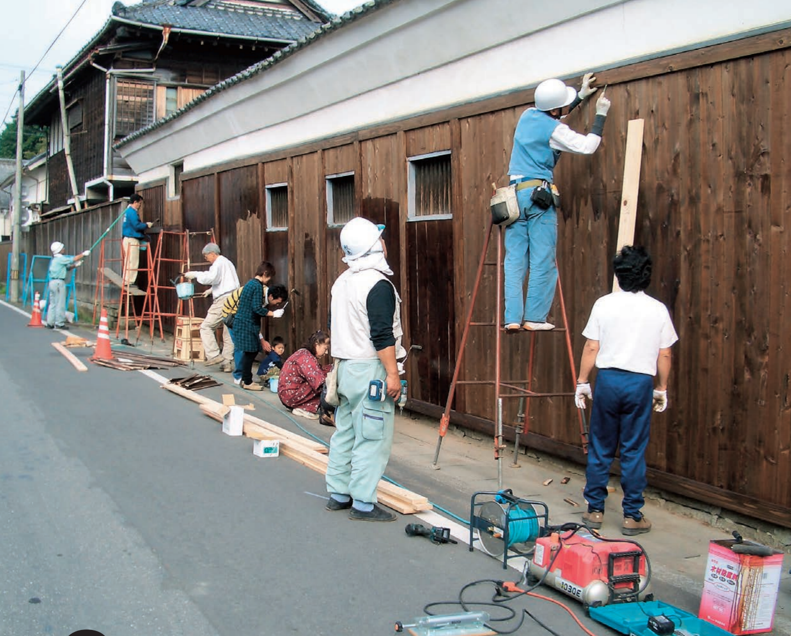
本会桜川支部による杉板塀を用いた修景作業
