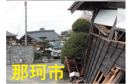
完全に倒壊した建物も見られた
