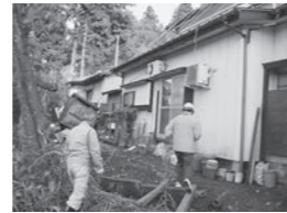
新潟県中越地震被災建築物判定活動
