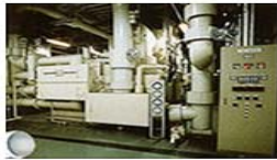
電動ターボ冷凍機
