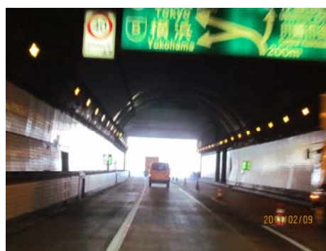
写真 1.4.1-2 大師トンネル内部
