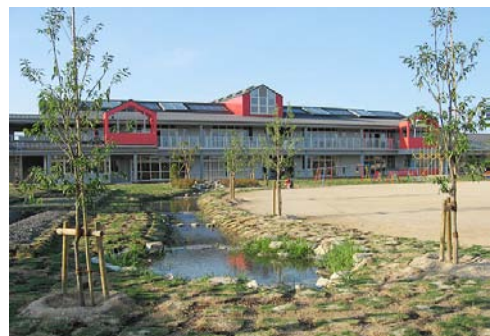
写真2.1.2-2 なのはな園外観 出典：「静里なのはな園」 8)
