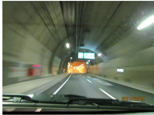
写真 1.4.1-4 山手トンネル内部
