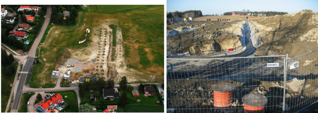
図2. 1. 2-16 ボーリング施工中の写真（左：全体図、右：パイプライン）
