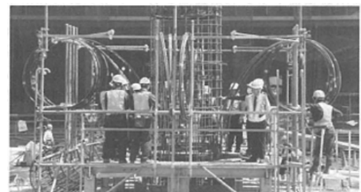
地中熱交換用チューブの基礎杭への取り付け 地中熱利用杭施工状況
