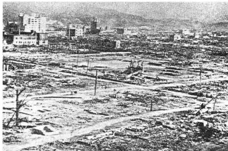
瓦礫の街原爆による廢墟と化した戦後広島市
