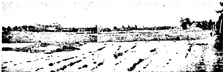
写139 九十九里町第八工区圃場整備工事 S 39.12.15 古川力撮影
