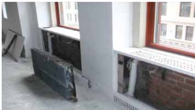
帝国大厦中，为靠大楼外墙一侧散热片安装绝热反射屏障
