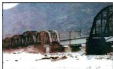
▲橋脚と橋の流失 (旧国鉄東海道線橋)
