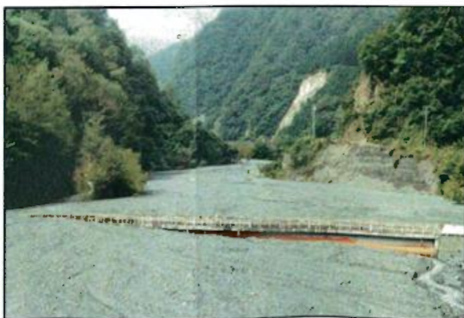
▲昭和57年8月洪水(台風10号)により大量の土砂流出
