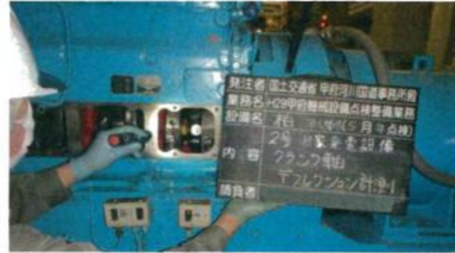
▲河川管理施設の点検
