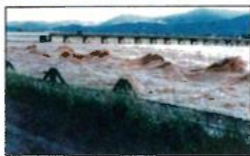
▲甲斐市「旧電王町」信玄堤 (信玄堤上流高速濁流、釜無川左岸)
