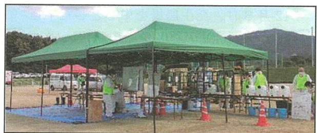
（防疫テント完成）
