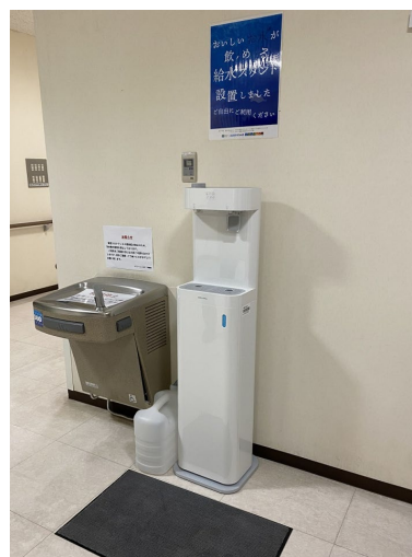
図4-29 プラスチックごみの削減や環境に対する意識啓発事業の一環として区有施設に設置したマイボトル対応型給水スポット
