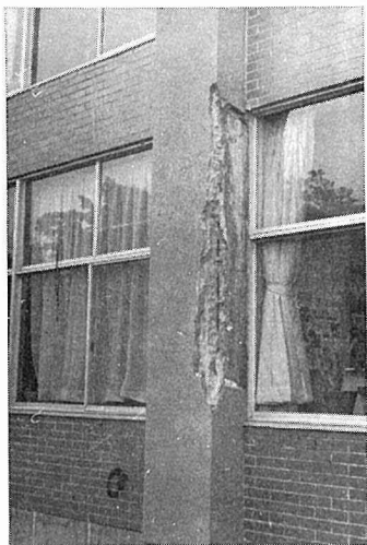
写真-13 根室支庁外壁柱
