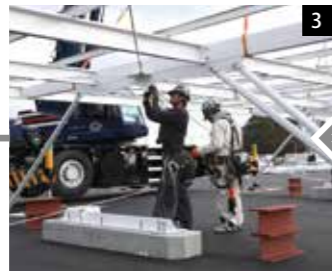
鉄枠に柱とブレースを取り付ける
