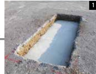
基礎を置く場所に捨てコンを打設する
