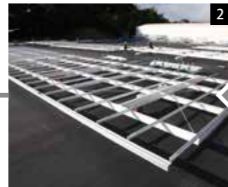
太陽光パネル取付台が完成
