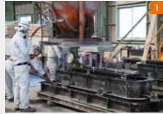
型枠に生コンクリートを打設する
