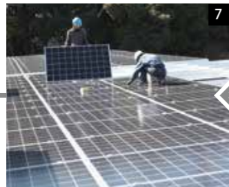
太陽光パネルの取り付け
