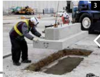
クレーンでプレキャストコンクリート基礎を搬入
