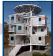
静岡事業所実験棟 ●鉄骨構造体
