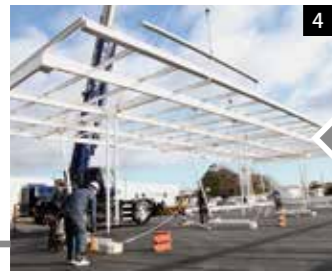
柱と基礎の位置を合わせる
