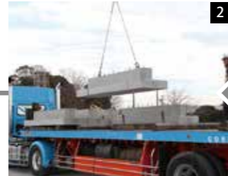
トラックでプレキャストコンクリート基礎を運搬
