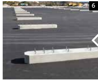
基礎工事完成
