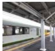
アルミ製ホーム上家 2008-2013年度 施工実績5棟
