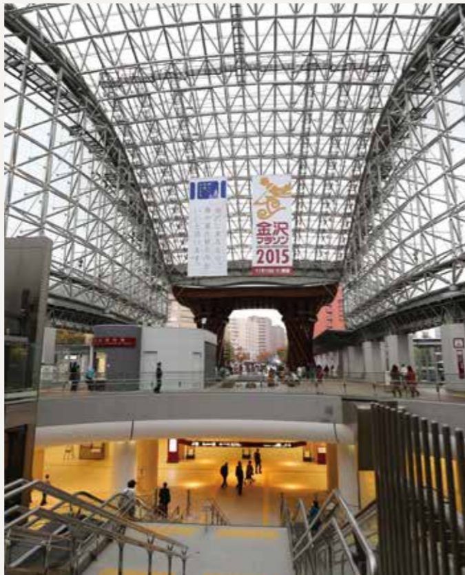
金沢駅東口の「もてなしドーム」。アルミ合金製トラス構造の屋根が大空間を覆う。
