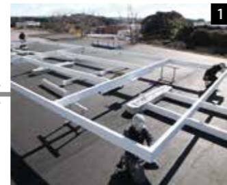
鉄枠の組み立て
