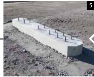
プレキャスト基礎完成
