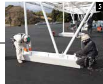
柱を基礎へボルトで固定
