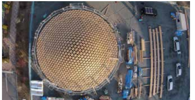
相馬こどものみんなの家。麦わら帽子をイメージした屋根は、板状の木を3層に重ねて組み上げたもの。構造はArup。(提供: クラインダイサムアーキテクト)
