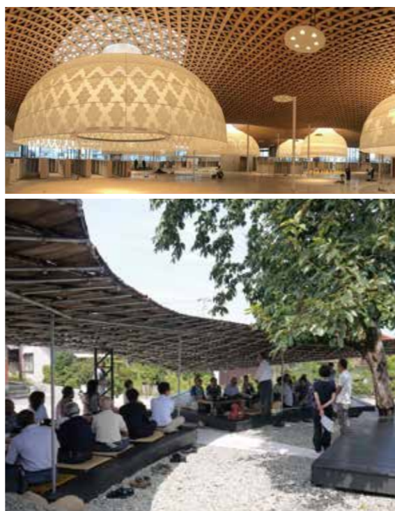
(上)みんなの森 ぎふメディアコスモス内観写真。(下)鳥キッチン。柱ほかの構造は水道管。屋根の杉板はボランティアにより定期的に張り替えられる。(提供: 金田充弘)
