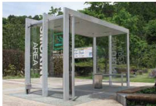
大分自動車道 玖珠SA 下り線 喫煙ブース
