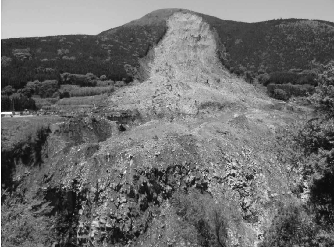
南阿蘇村阿蘇大橋付近の斜面崩壊 (5/12 岩楯撮影)
