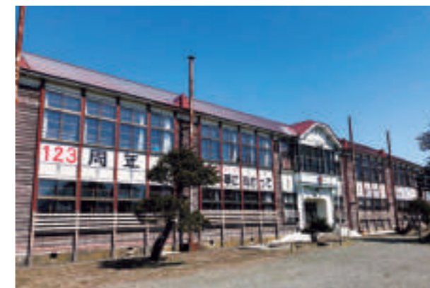
道内最古の木造校舎・弁華別小学校
