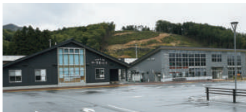
平成30年に完成した「こ・らっしゅ」(右)と令和元年完成の「や・すまっしゅ」(左)
