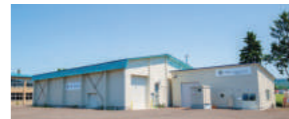
体育館を再利用した工場(左)と増設した事業所(右)
