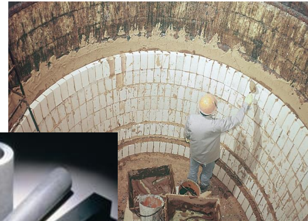
耐火れんが の築炉
