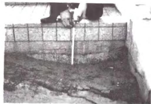
図2-16 局舎ととう道の接合部の被害 写真2-7 北郷局周辺(地盤沈下約20cm)
