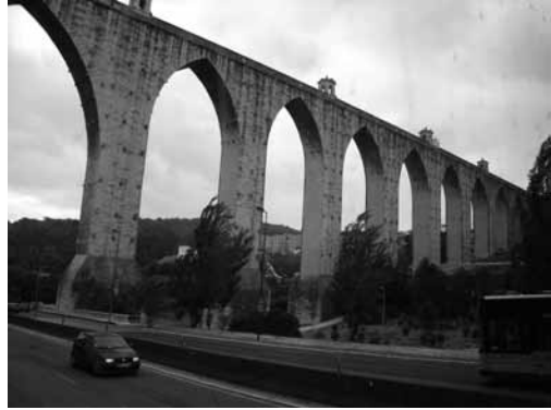
写真8 アグアス・リブレス水道橋
