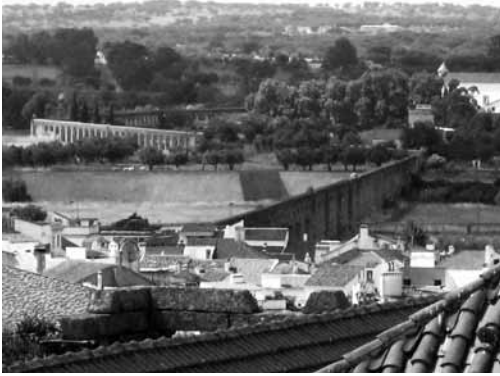
写真3 カテドラル屋上から見たエヴォラの水道橋
