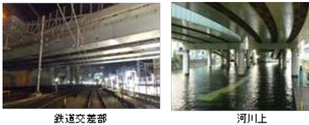
図-1 高架下の近接施設
