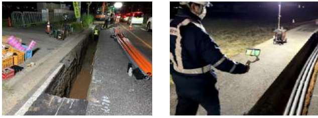
図-8 現場と計測の状況
