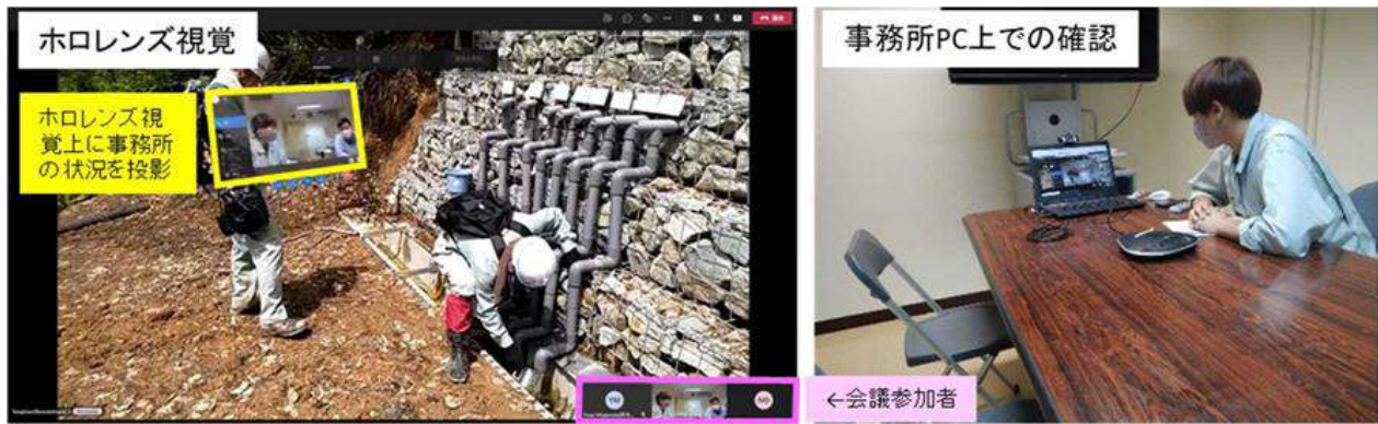
図-1 地すべり対策工 流量測定現地立会状況(左:PC画面、右:事務所)
