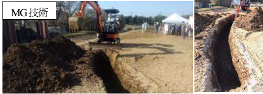
写真2 小規模土工（管路掘削）検証状況 （丁張りレスによる湾曲掘削）
