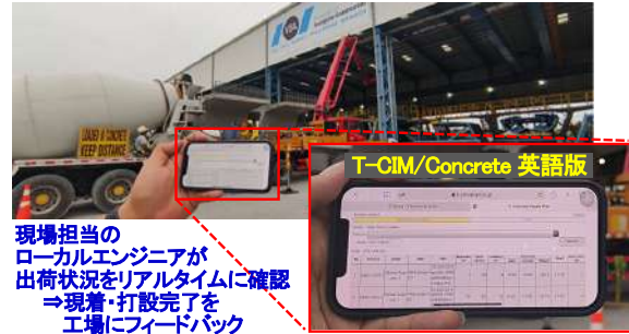
図-11 施工現場での出荷/運搬情報の参照状況
