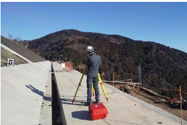
図-6 実証実験現場での様子
