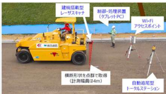
図6 路盤面の計測状況
