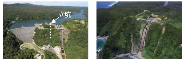
福地ダム 堤体
