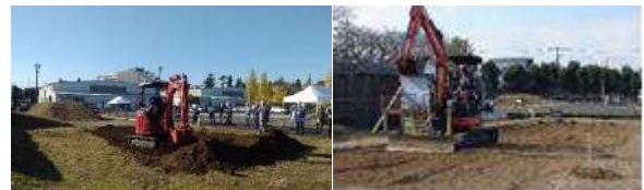
写真1 小規模土工（敷均・整正）検証状況
