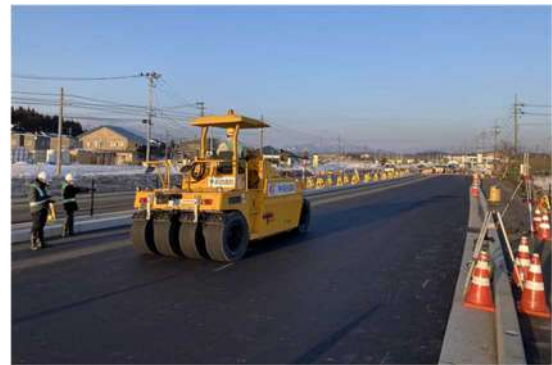
図-9 アスファルト舗装面の計測状況
