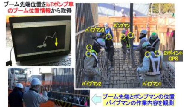
図-10 実施工における作業履歴の取得状況(塩浜立体での試行)
