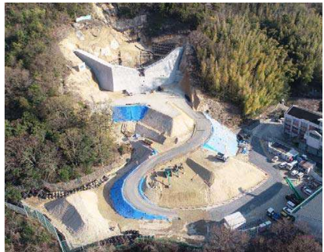
図-1 工事着手前全景写真
