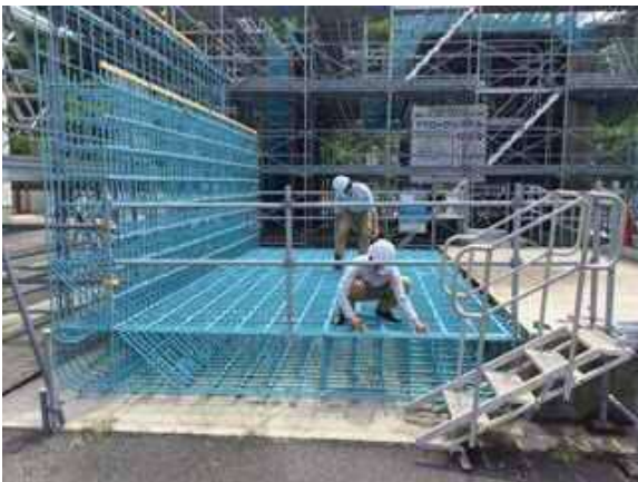
写真-2 マーキング状況
