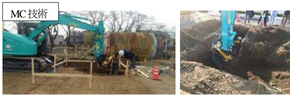
写真3 小規模土工（管路掘削）検証状況 （丁張りレスによるL字掘削）
