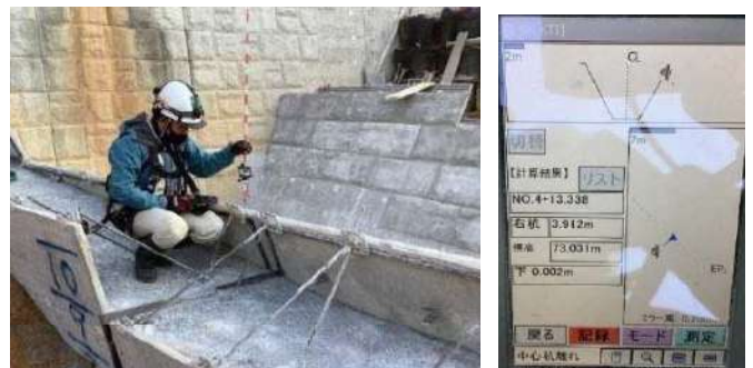
図-13 構造物TS管理状況
