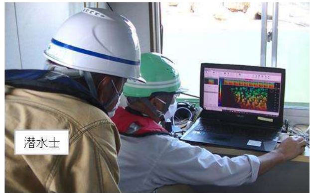
写真-3 潜水士が船上からブロック据付を指示
