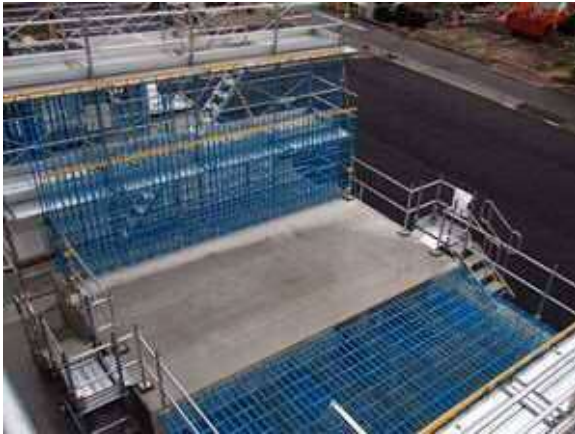
写真-1 ボックスカルバート供試体
