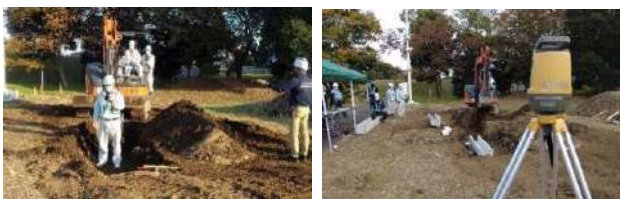
写真4 構造物設置工 検証状況
