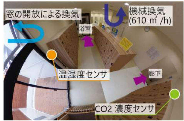
図-2 西側脱衣室とセンサ設置箇所（東側も同様）
