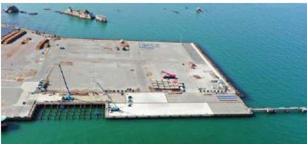
図-1 施工状況全景
