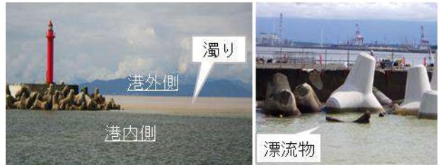
写真-2 大雨の影響による現場の状況
