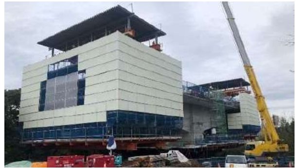
(b) 施工状況
