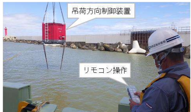
写真-4 船上からリモコンで吊荷ブロックの向き調整
