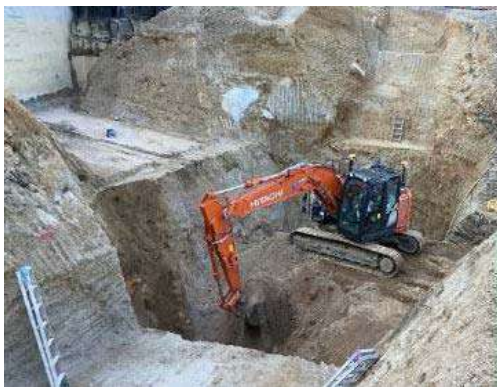
図-8 MCBHによる掘削・床掘状況
