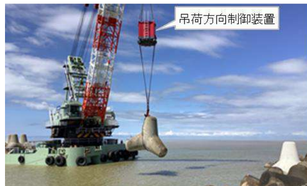
写真-1 吊荷方向制御装置による吊荷の回転制御
