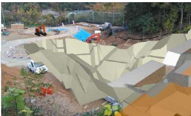
図5 掘削・床掘AR
