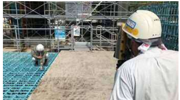
写真-3 トータルステーション測量状況
