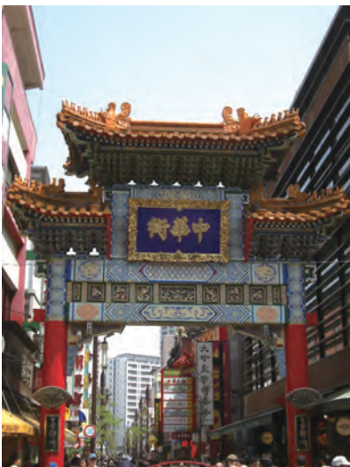
写真1 現在の善鄰門
