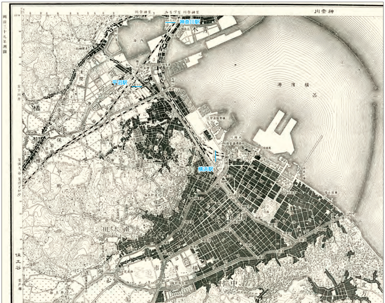
図2 スイッチバック構造となった頃の初代横浜駅付近
