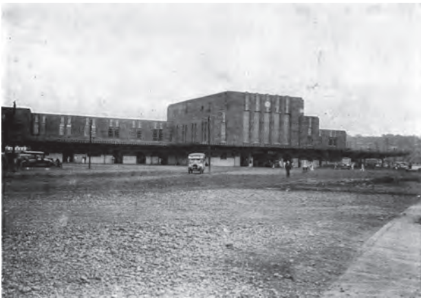
図8 3代目横浜駅の姿(昭和3年10月開業～昭和51年まで使用)旧線路敷撤去地ならしのままの未整備駅前状況。さらに右手に都市計画による広い電車通りが設けられた。『日本地理風俗大系3 関東南部』新光社 昭和5所収 p.176)
