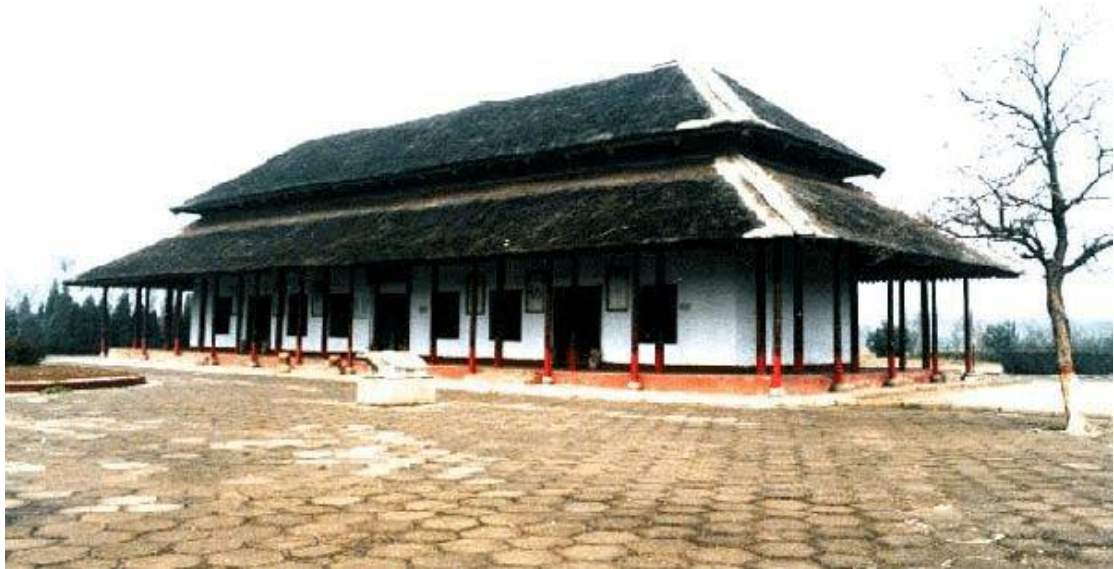
河南安阳殷墟
