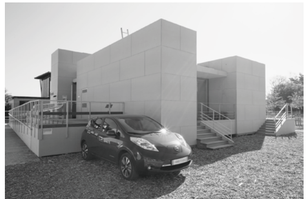
竣工した「ルネ・ハウス」
